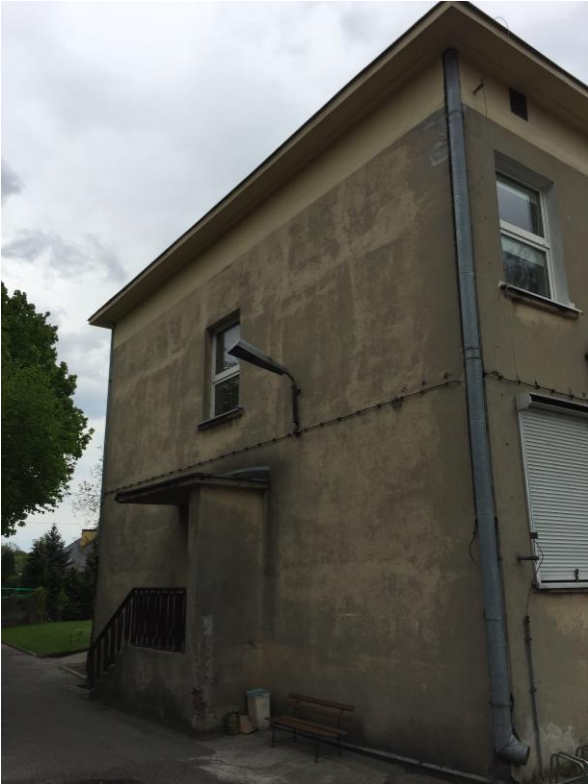
Elewacja północna skrzydło zachodnie- schody wejściowe
