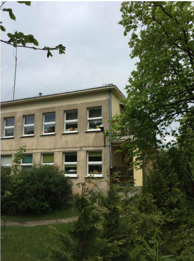
Elewacja południowa – skrzydło południowe – zadaszony taras i balkon od strony wschodniej
