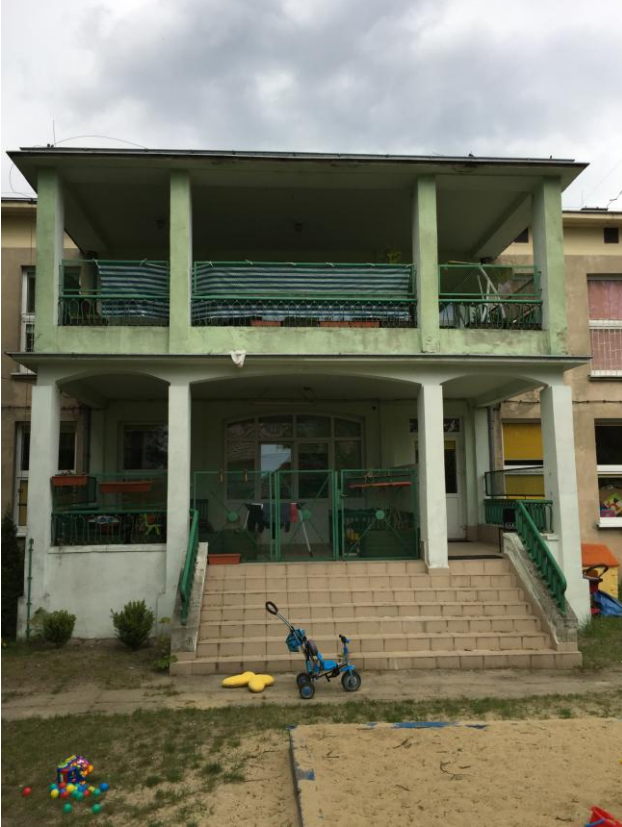
Elewacja południowa – skrzydło południowe -zadaszony taras i balkon
