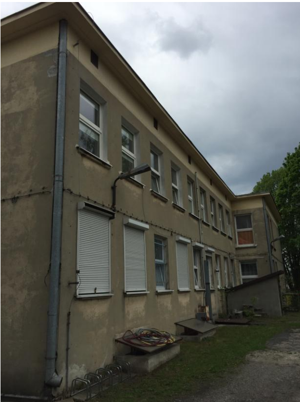
Elewacja zachodnia – skrzydło zachodnie – kosze , obudowane wejście zewnętrzne do kotłowni
