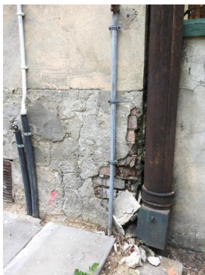
Ubytki w ścianach piwnic
